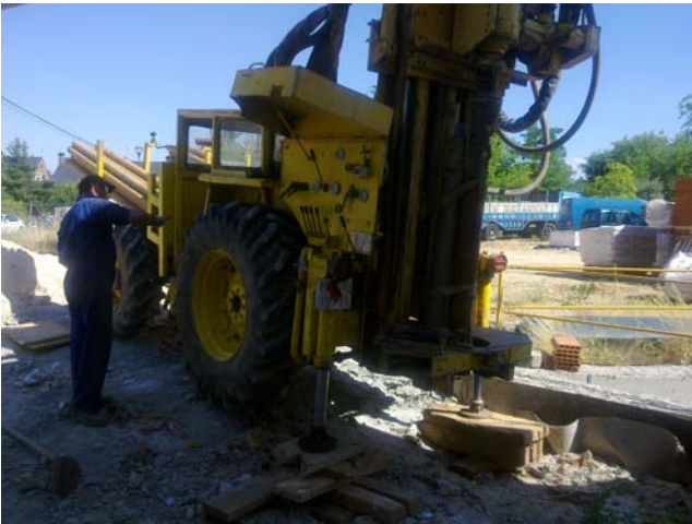
EJECUCIÓN DE SONDEOS
